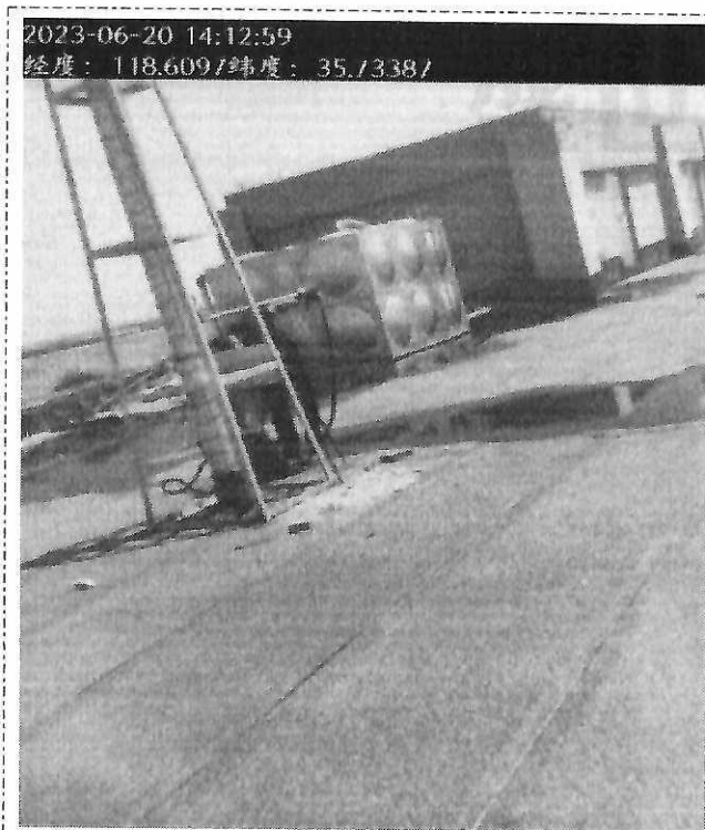
图 1: DA024 新密炼炭黑投料排气筒现场监测图
